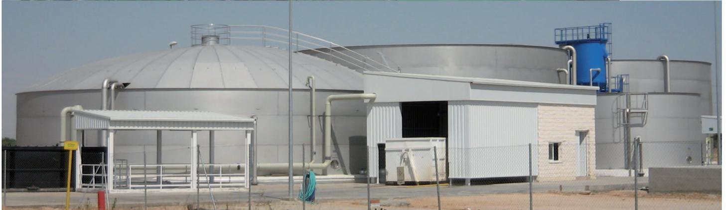
Sistemas de homogeneización, tecnología DAFAST y reactor biológico S.B.R. para nitrificación-desnitrificación
